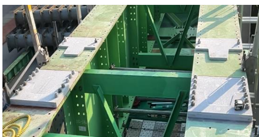
STEP-4 (多軸台車前進) 仕口連結完了
