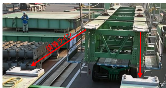
STEP-1 (多軸台車前進) 仕口連結前
