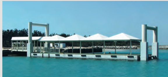
竹富浮栈橋:2004年 RCハイブリッド浮栈橋 2面(1面あたり:幅10m× 長さ35m×高さ2.55m、 重量523t)であり、揺れの 低減のためMSボードを採 用しています。
