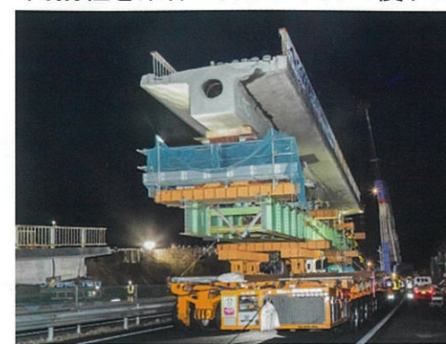
■メタル桁の輸送・据付(ステージジャッキのストロークを利用して橋脚高さまで持ち上げて輸送架設)
